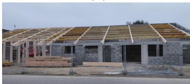
Travaux au 23 décembre 2025
