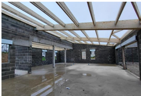
Travaux au 23 décembre 2025
